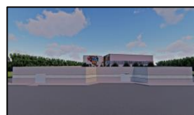
Figura 7 - Fachada Frontal - Muro
