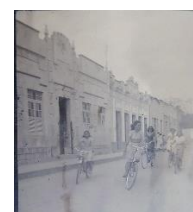
Figura 03- Fachada antes das modificações
