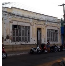
Figura 04- Fachada após modificações
