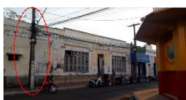
Figura 06 - Poste de Iluminação
