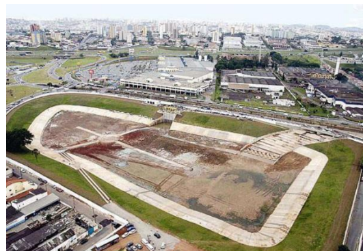
Figura 3- Piscinão da Vila Pauliceia, em São Bernardo (SP), com capacidade para absorver 380 milhões de litros de água.
