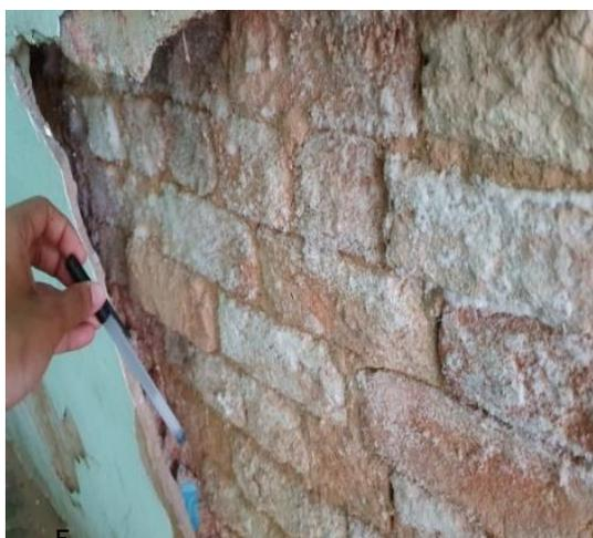
Figura 04 - Desplacamento de elementos da argamassa.
