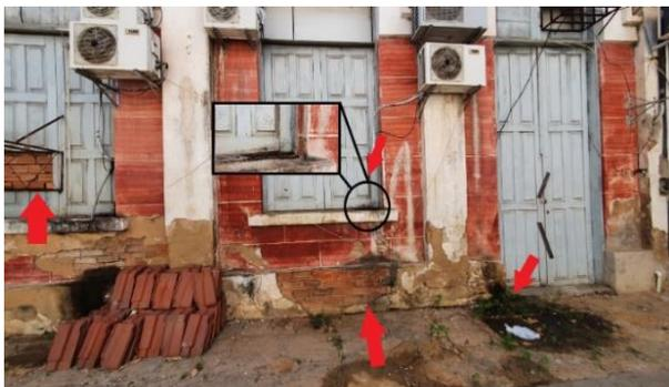
Figura 03: Manchas de umidade, deslocamento de argamassa, Deterioração das esquadrias
