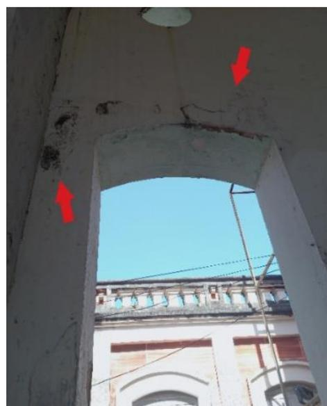
Figura 03- Fissuras por concentração de tensões e manchas de umidade.
