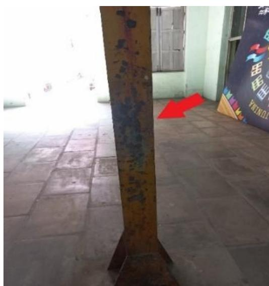
Figura 01: Corrosão no pilar.
