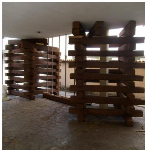
Figura 3. Escoramento com madeira
