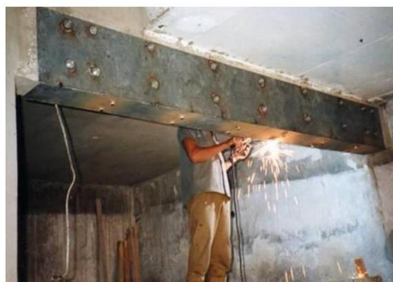
Figura 5. Reforço em uma viga
