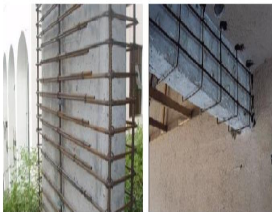
Figura 4. Reforço por encamisamento
